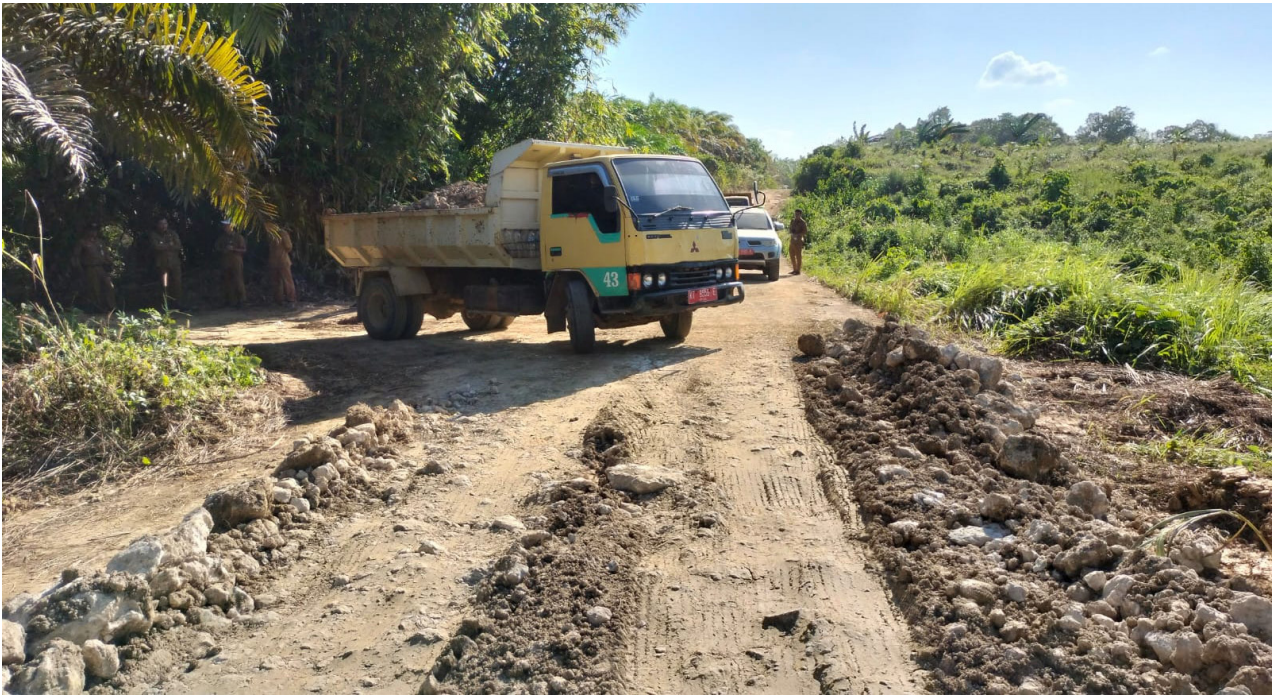
Perbaikan jalan penghubung Batu Engau-Tanjung Harapan (TB/Media Kaltim)
