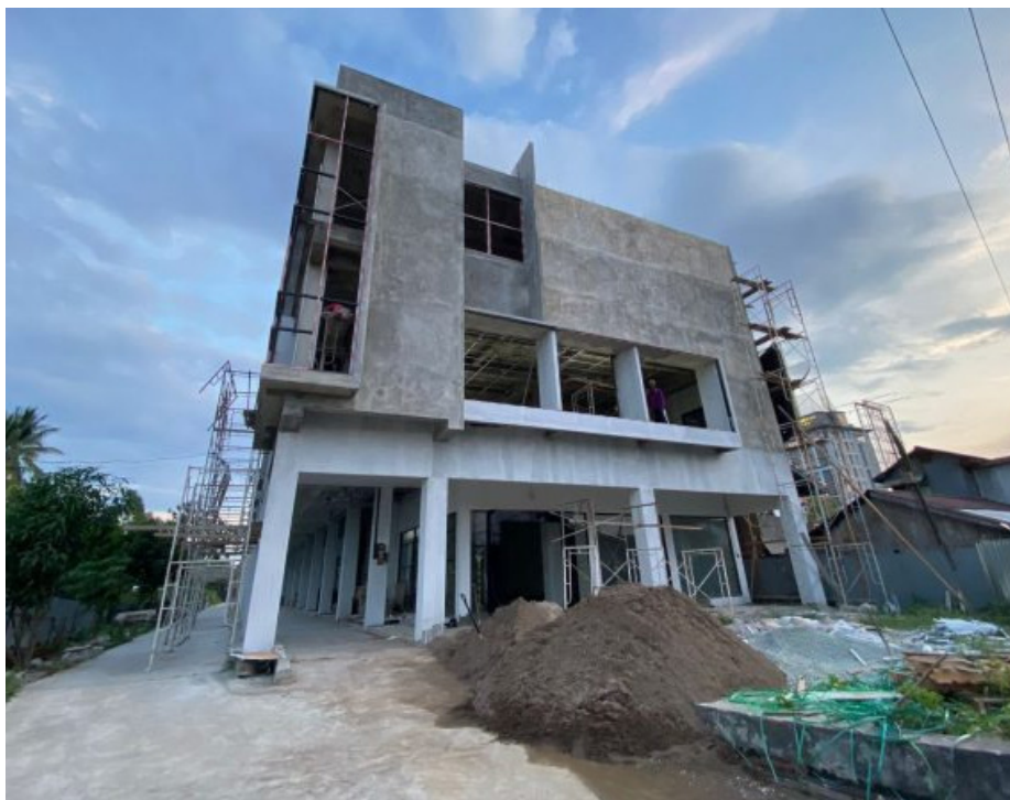
Lanjutan pembangunan gedung Disbudpar Berau yang baru sudah mulai memperlihatkan bentuk gedungnya.
