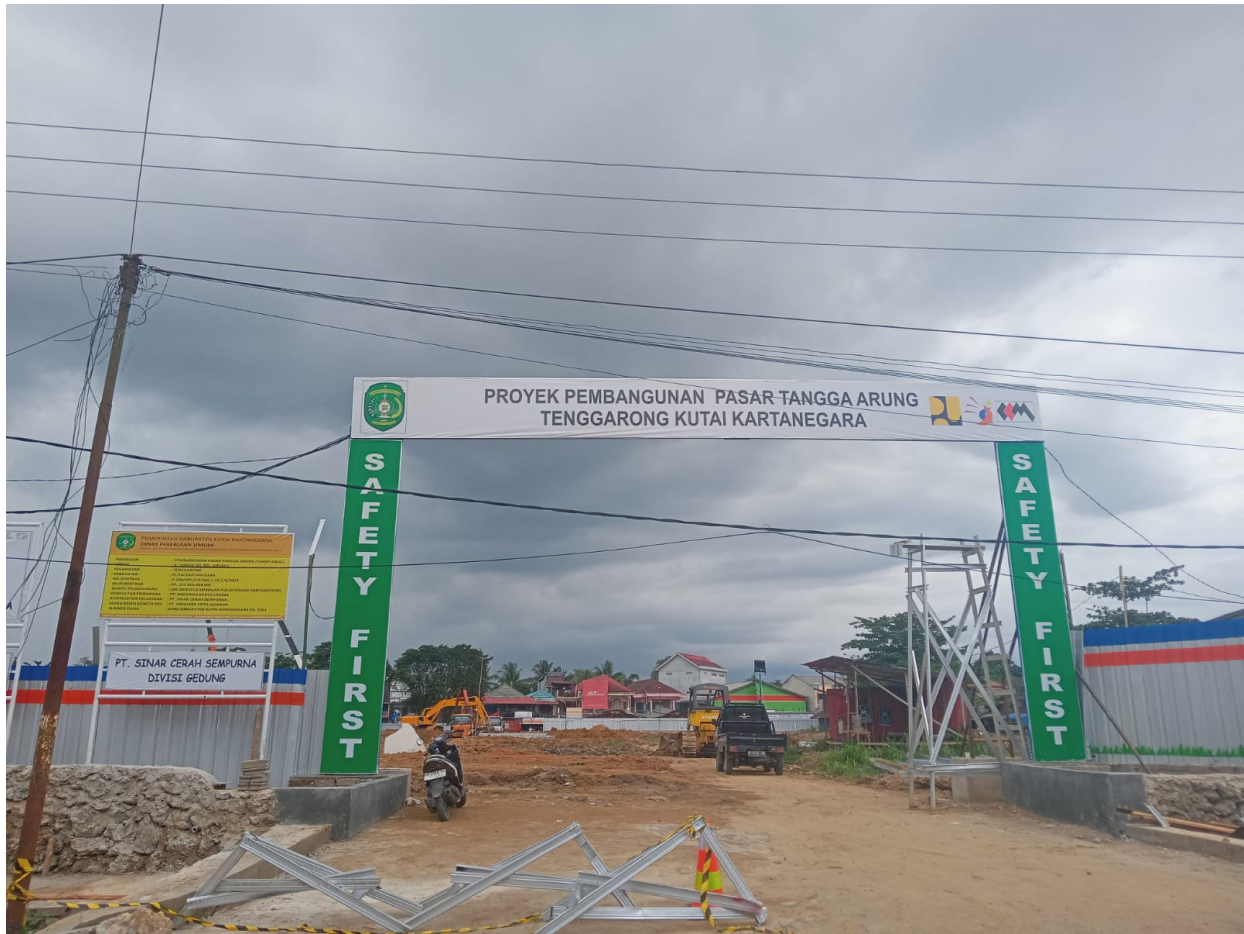
Proses Pembangunan Pasar Tangga Arung (Ady/Radar Kukar)
