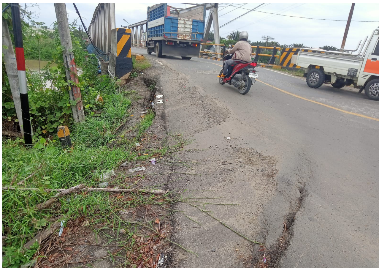
Oprit jembatan di Kecamatan Paser Belengkong. Jembatan ini merupakan penghubung jalan nasional.
